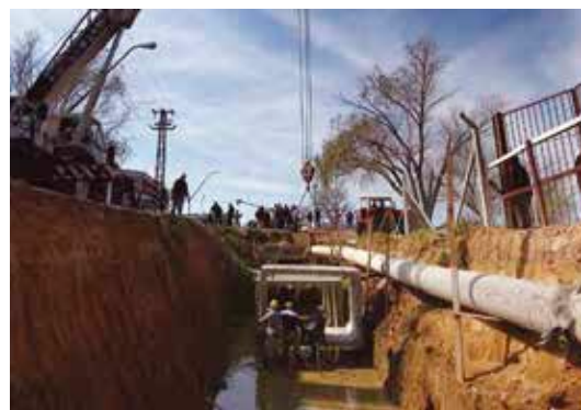
Obras de desagües en el norte de la ciudad.
